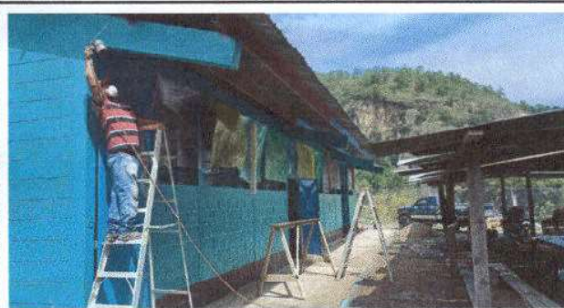
Foto 2: Pintura en muros exteriores.
