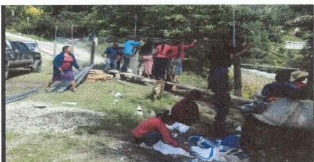
Foto 5: Reparación de malla galvanizada.
