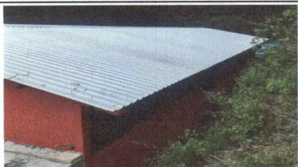
Foto 1: Sustrucción de lamina por lamina troquelada aluzinc calibre 26 modulo de aulas.
