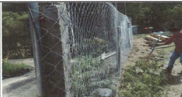
Foto 6: Reparación de malla galvanizada.
