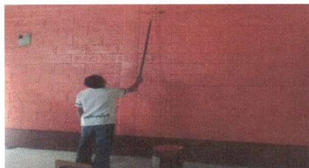
Foto 3: Pintura de muros interiores de modulo de aulas.
